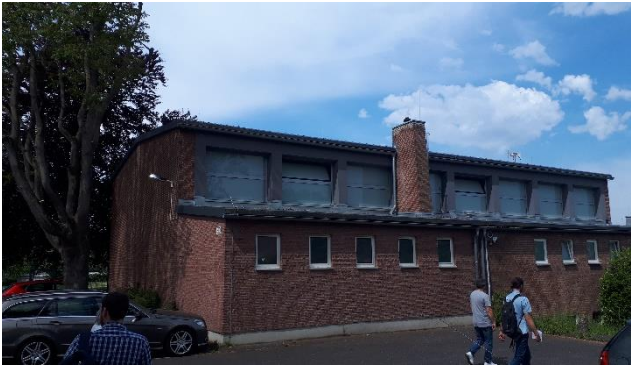
Abbildung 1: Ost Ansicht des Gebäudes
