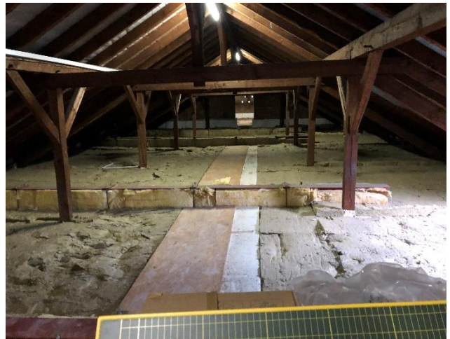
Abbildung 4: Dachkonstruktion Satteldach IV / V
