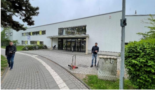
Abbildung 1: Nordwestansicht des Gebäudes
