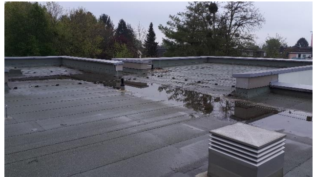
Abbildung 4: Flachdach Südwestansicht obere Hälfte
