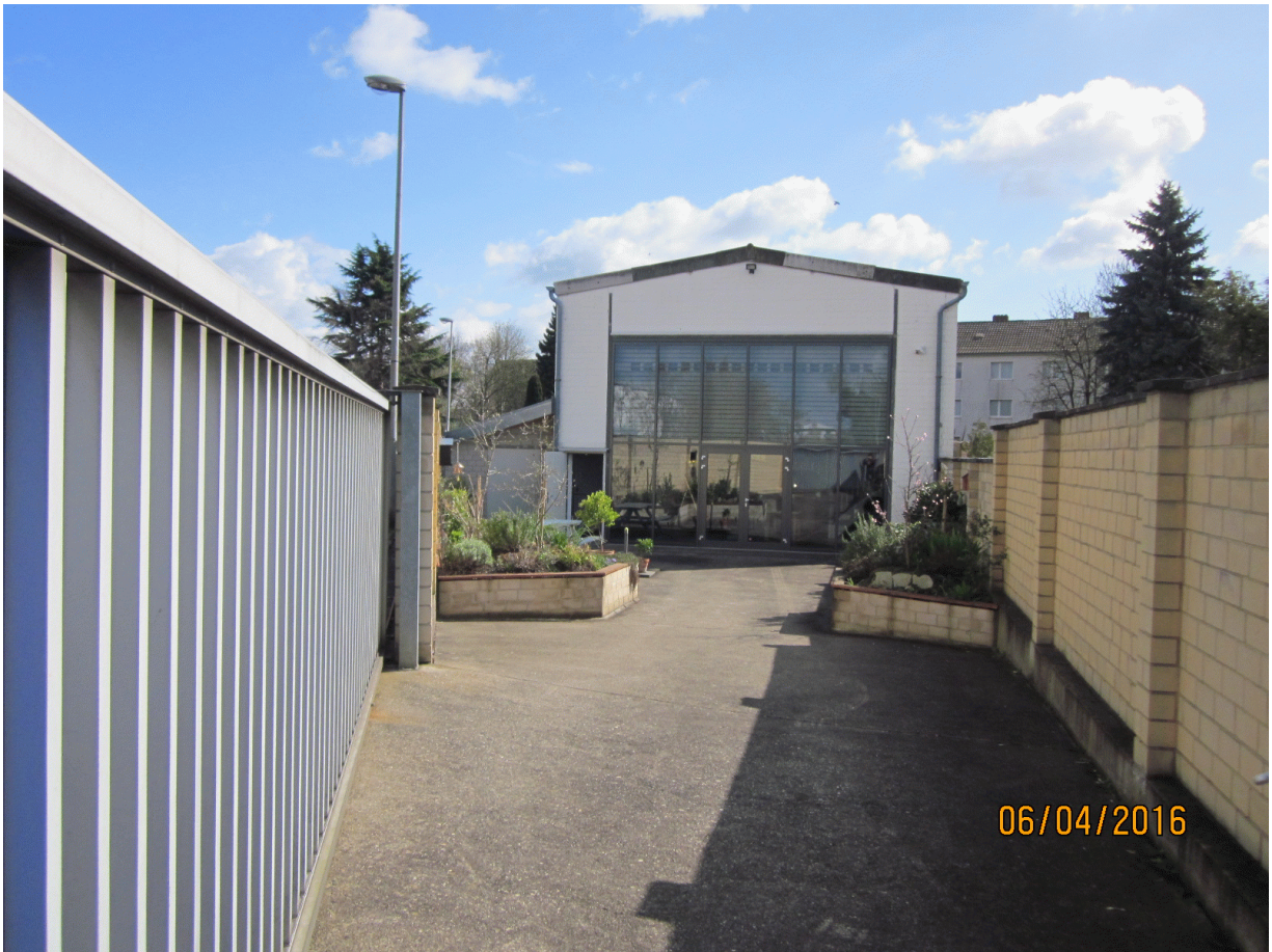
Abb. 7: Weißer Straße 2, Westfassade
