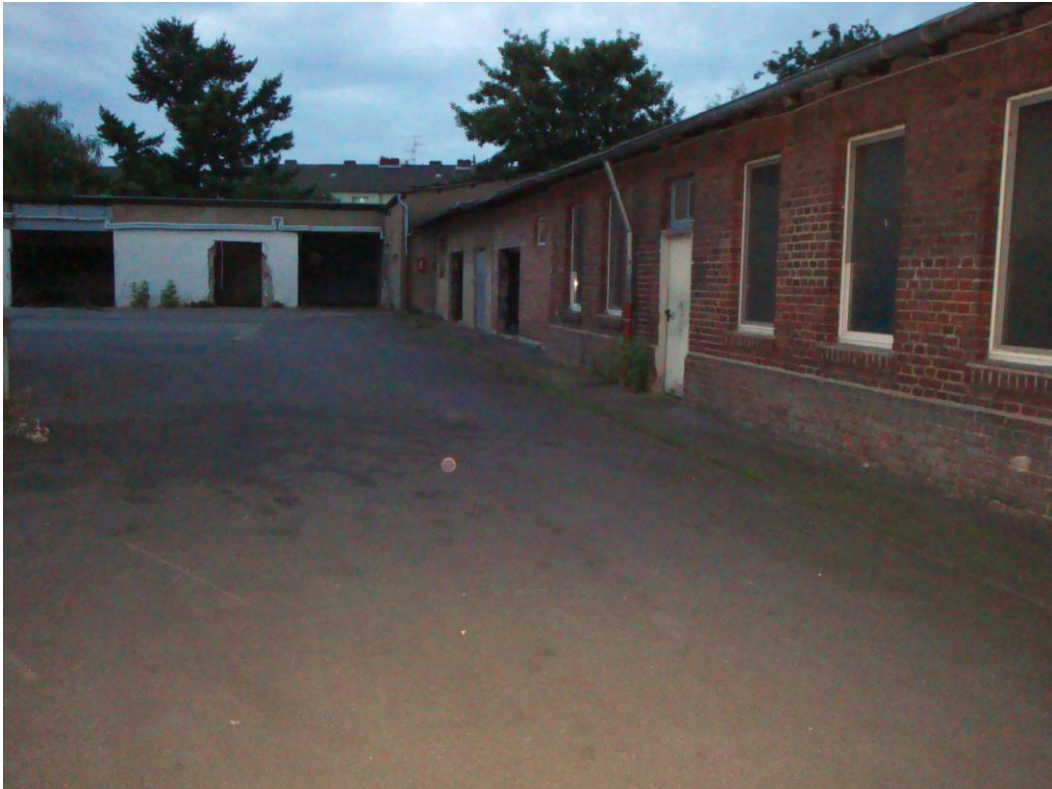
Abbildung 4: Alte Arbeitsbaracken im Süden
