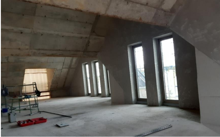
Dachgeschoss (Dritter Stock) der neuen Stadtbibliothek Brühl
